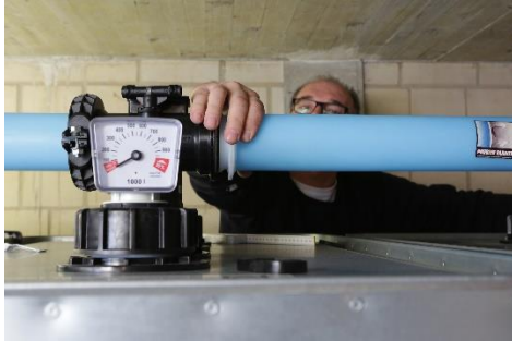
Die bauseitige Füll- und Entlüftungsleitung – hier aus LORO-X-Rohr – wird mit Entlastungsbogen verlegt.
