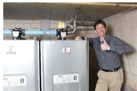
Nach einem Tag kann die neue Heizöltankanlage dem Bauherren übergeben werden.
