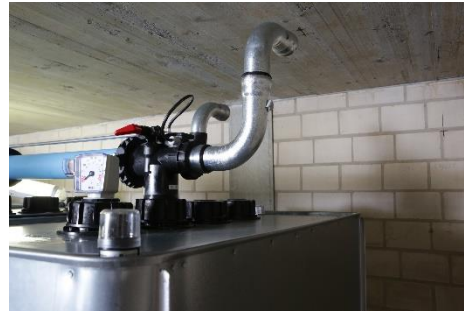
Die bauseitige Füll- und Entlüftungsleitung – hier aus LORO-X-Rohr – wird mit Entlastungsbogen verlegt.
